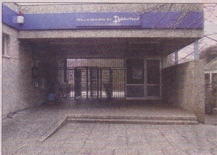
Der Eingangsbereich des Ohlsdorfer Hallenbades zeigt sich wenig einladend. Die Modernisierung des Hallenbades soll über den Verkauf von Außenflächen finanziert werden.
